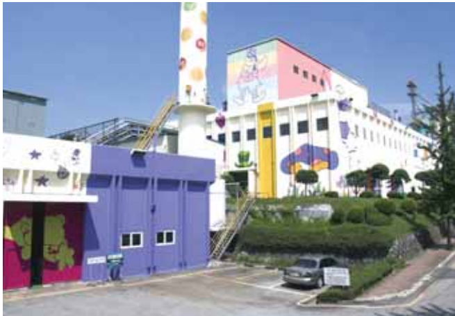
▲ 샘표 이천공장 아트팩토리 전경
